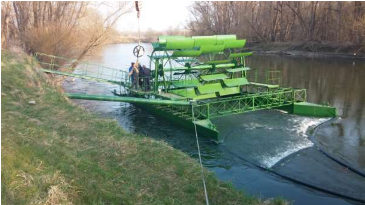
10. ábra: Úszó mini vízerőmű telepítés közben
